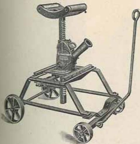
N° 7130. — Chariot pour le montage et le démontage des induits de motrices. Type à crémaillère avec déplacement latéral.
