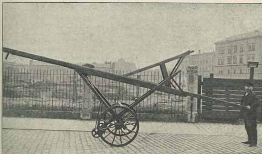
Echelle de réparation pouvant rouler sur rails.
