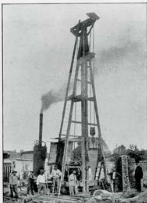
Exécution des puits de fondation
