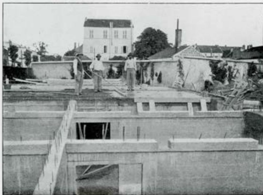
Confection des sous-sols étanches et des planchers en béton armé
