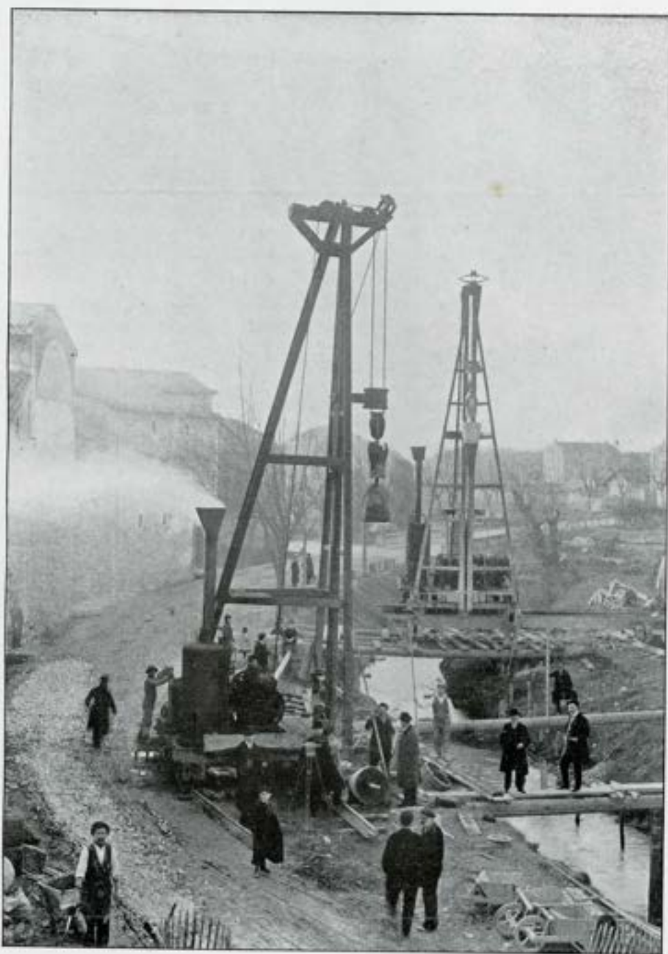
Fondations des culées
