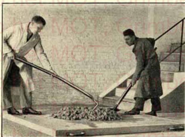
Fig. 11. — Malaxage du béton.
