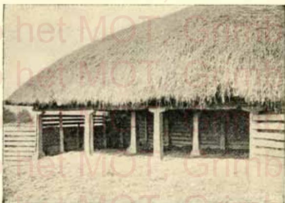
Fig. 29. — Supports en béton armé
