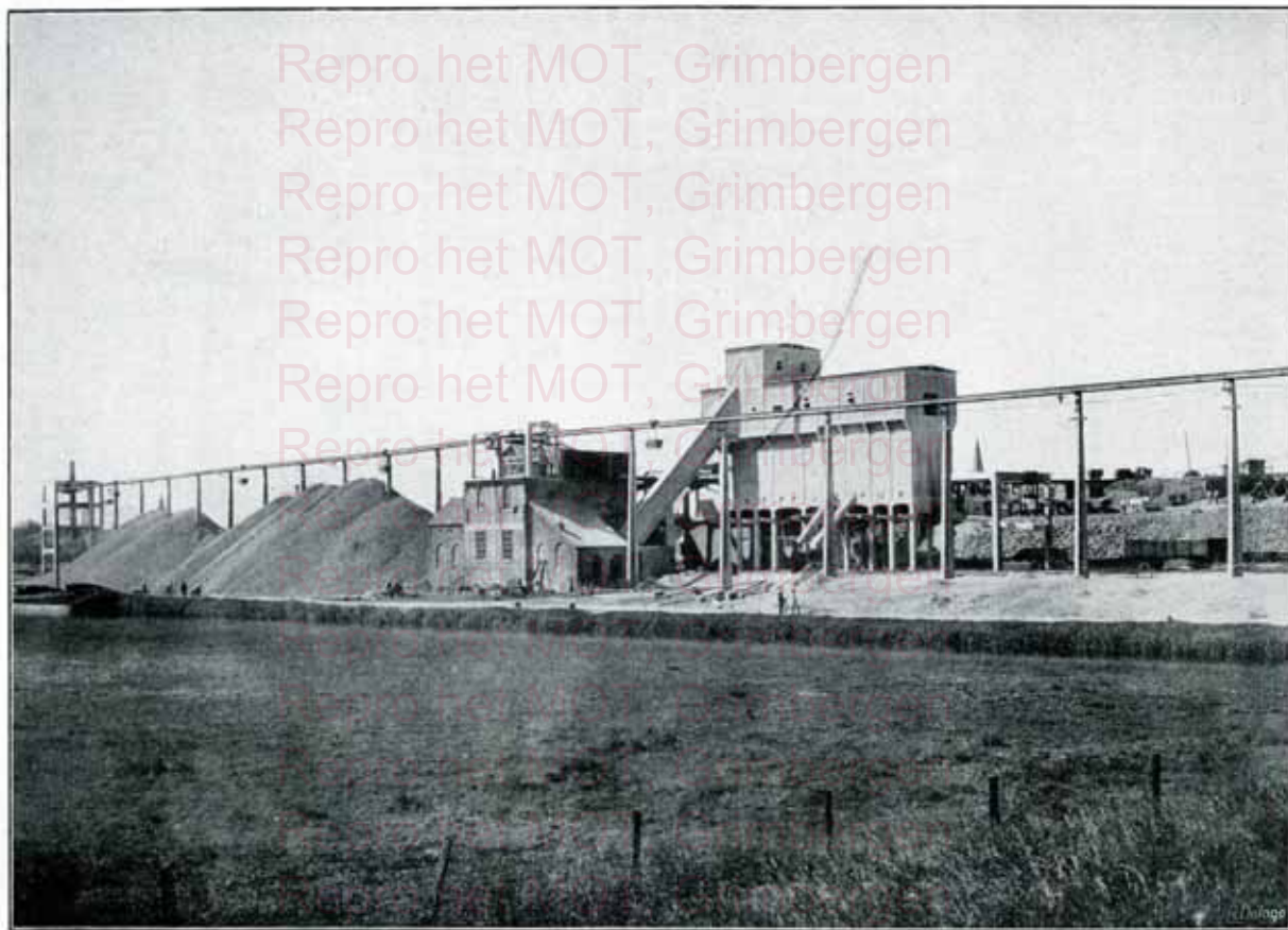
Fig. 21. — L'une des multiples usines à concasser des carrières de porphyre de Lessines. — Mise en stock automatique le long de la Dendre.
