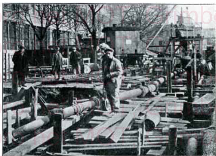
Fig. 41. — Distribution du béton par l'air comprimé.
