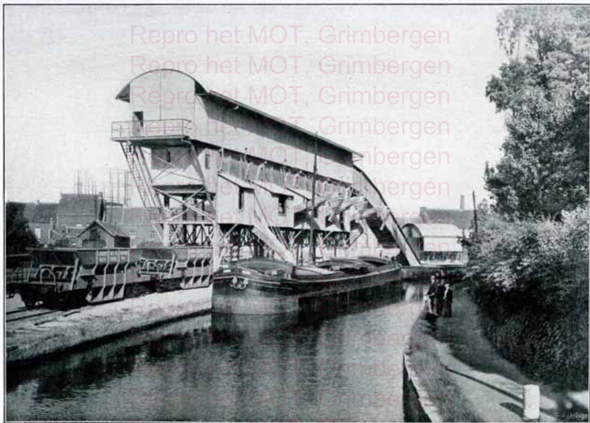
Fig. 21 bis. — Carrière de Porphyre de Lessines. — Chargeur mécanique de bateau le long de la Dendre.
