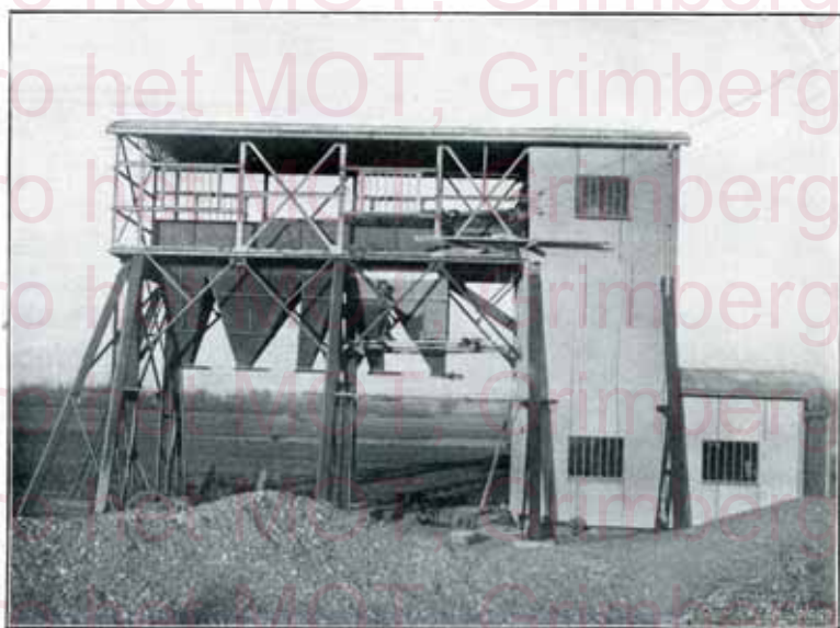
Fig. 27. — Usine de concassage de galets de la Société Anonyme d'Entreprise Générale de Travaux
