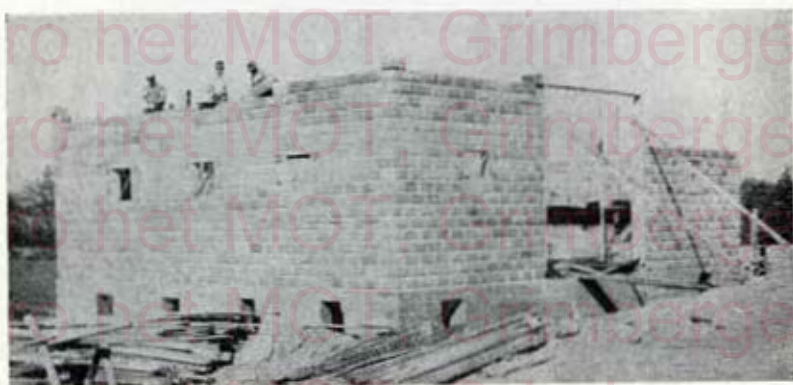
Fig. 29. — La maçonnerie en blocs de béton résiste aux intempéries et à l'incendie. Son aspect est agréable, son exécution rapide.
