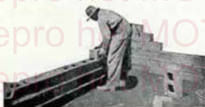
Fig. 3. — Pose du bloc creux en béton, en le saisissant par la cloison formée par deux alvéoles.
