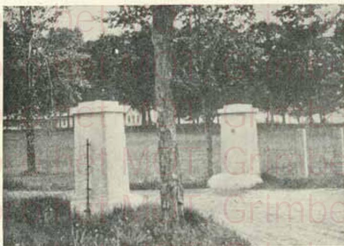
Fig. 29. — Pilastre monolithe moulé sur place.
