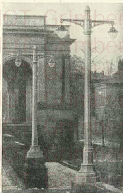
Fig. 26. — Lampadaires en béton.
