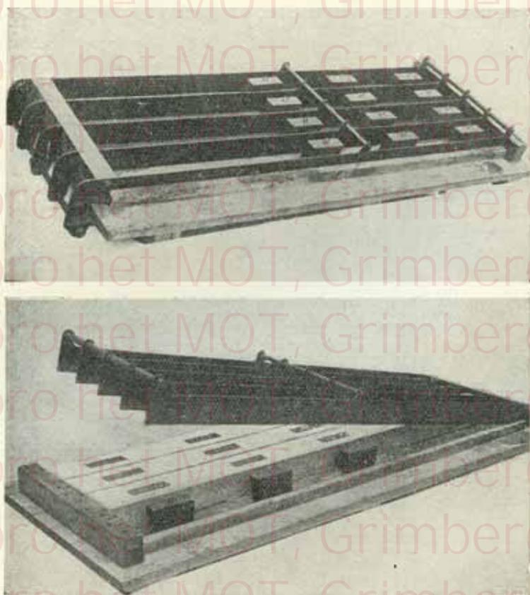
Fig. 11. — Moules pour pieux en béton, fermés et ouverts. ■
