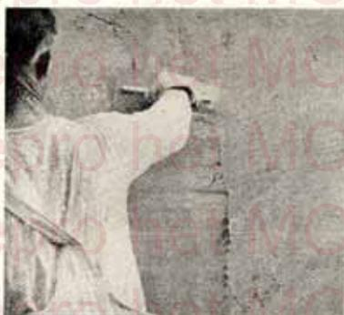
Fig. 17. — Pose à la truelle de la mince couche de finissage.
