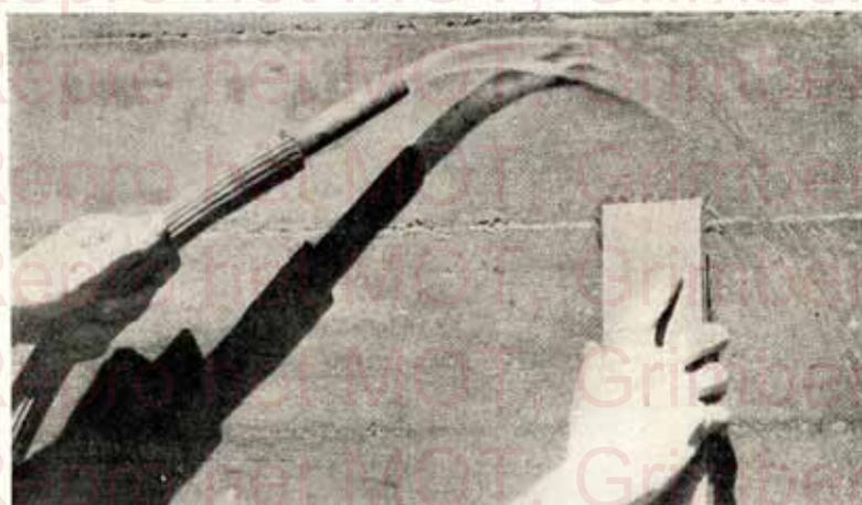
Fig. 3. — Lavage de la surface après traitement à l'acide.
