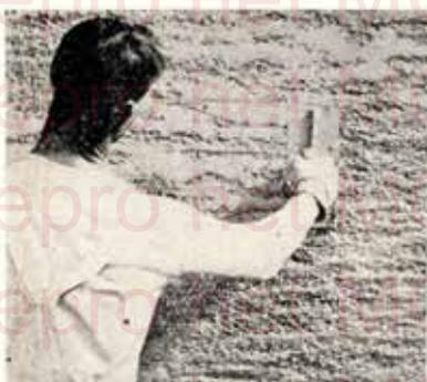
Fig. 43. — Nivellement des parties saillantes.
