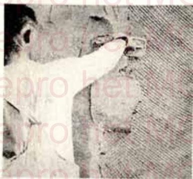
Fig. 25. — Pose de la couche de finissage.
