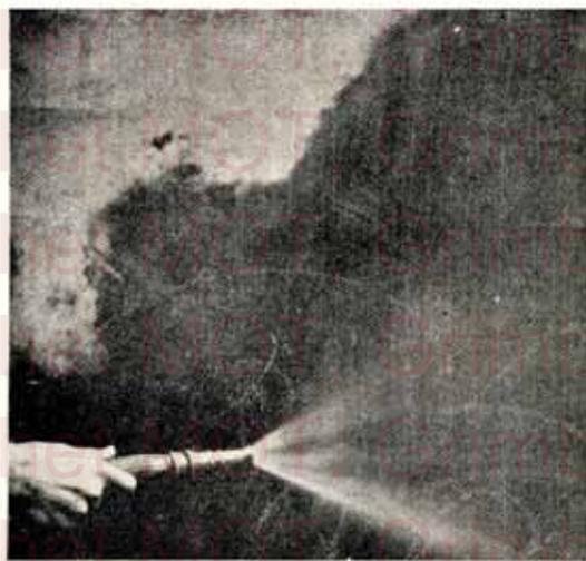
Fig. 8. — Le jet d'eau pulvérisé est recommandé pour obtenir une humidification convenable et réaliser une succion uniforme.
