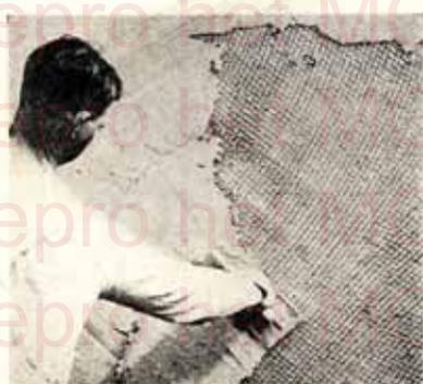
Fig. 49. — Pose de la couche de finissage.
