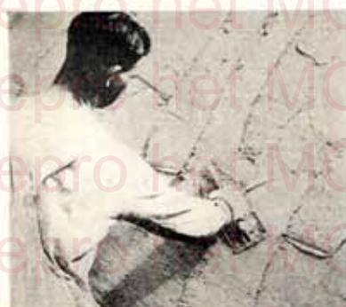
Fig. 51. — Les traces de la truelle doivent apparaître en surface.
