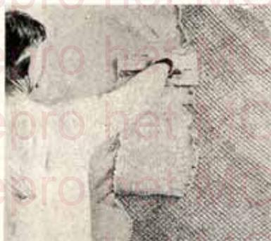
Fig. 45. — La couche de finissage est posée par bandes verticales.
