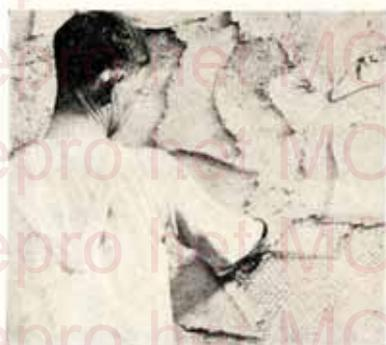
Fig. 29. — Application de la couche de finissage.
