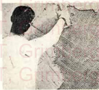
Fig. 50. — L'enduit est posé par bandes sensiblement parallèles.
