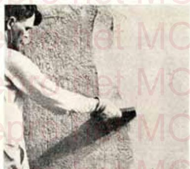
Fig. 47. — Travail de la surface avec l'arête du bloc de bois.
