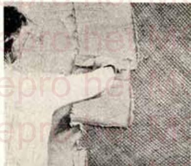
Fig. 41. — Application d'une couche de finissage épaisse.
