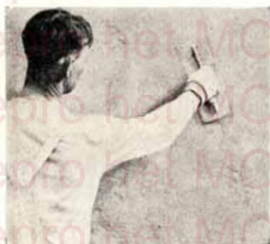
Fig. 31. — Lissage des parties les plus en relief.
