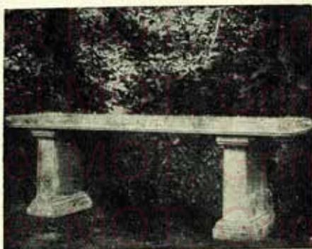
Fig. 27. — Banc de jardin en béton.
