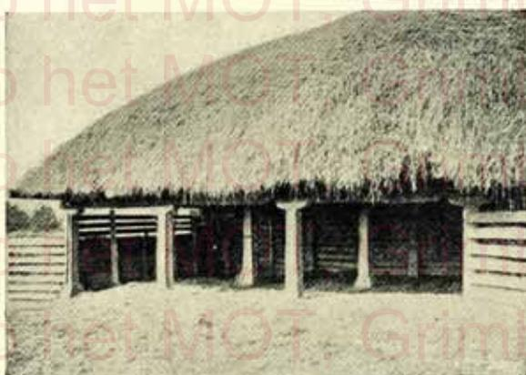
Fig. 29. — Supports en béton armé
