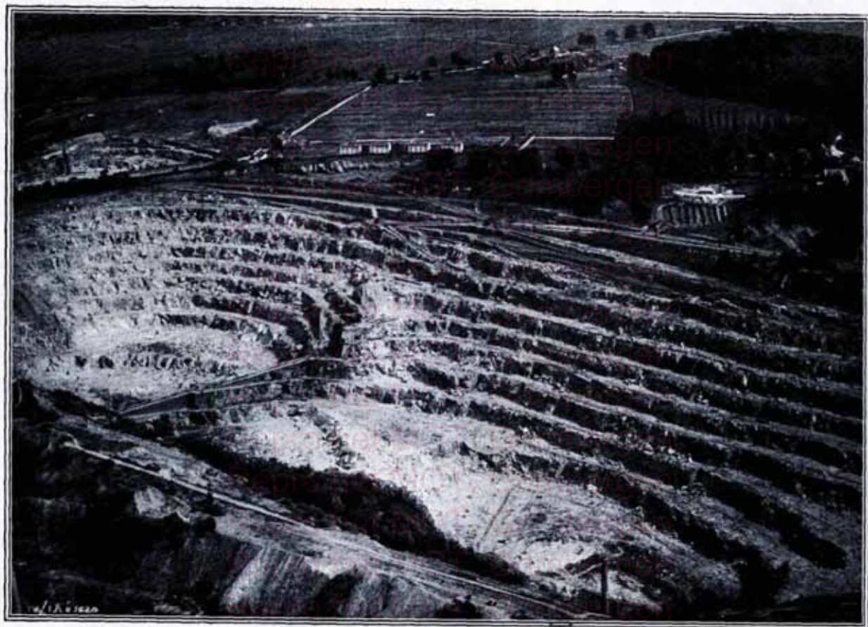
Carrières de porphyre de Quenast. Vue générale de l'une des carrières (Reproduction interdite). Cliché obligeamment prêté par « La Technique des Travaux ».
