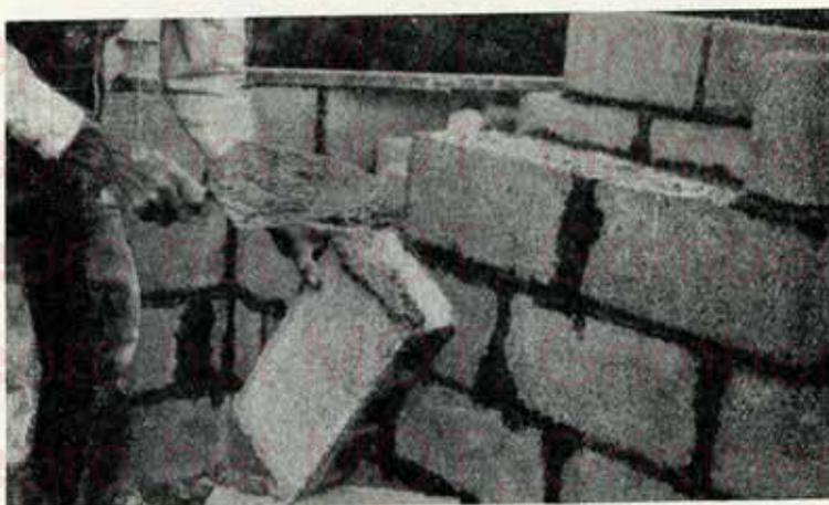
Fig. 26. — La pose du mortier se fait à la truelle.
