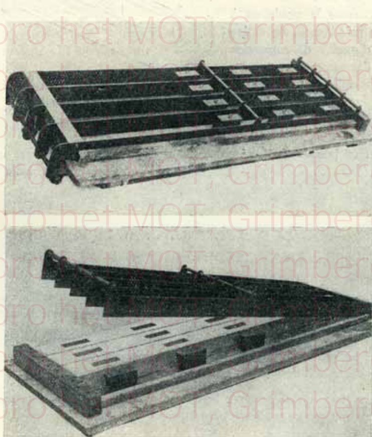
Fig. 11. — Moules pour pieux en béton, fermés et ouverts.
