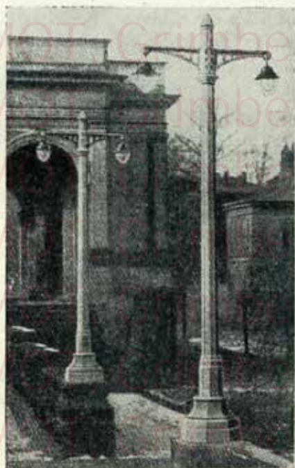
Fig. 26. — Lampadaires en béton.
