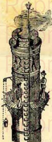
Construction en briques ordinaires, radiales et en briques résistant aux acides; faite à la main ou au moyen d'assenseur à vapeur ou électrique.
