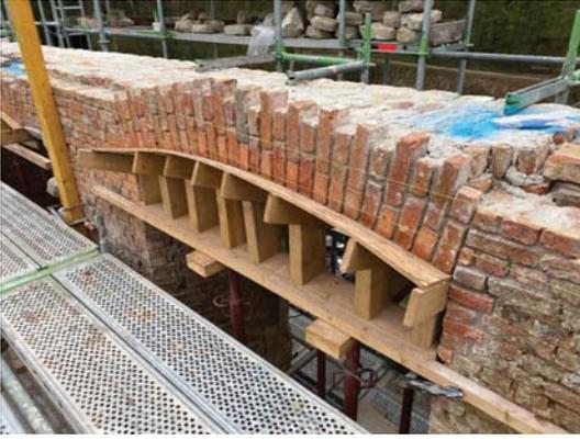
De kasteelmuren bestaan zowel uit baksteen als uit natuursteen. **Waar mogelijk worden de stenen terug op hun plaats gemetst.** Sommige stenen zijn zo beschadigd dat ze vervangen worden, tot nu toe kon dat met recuperatiematerialen van het Prinsenkasteel zelf.
